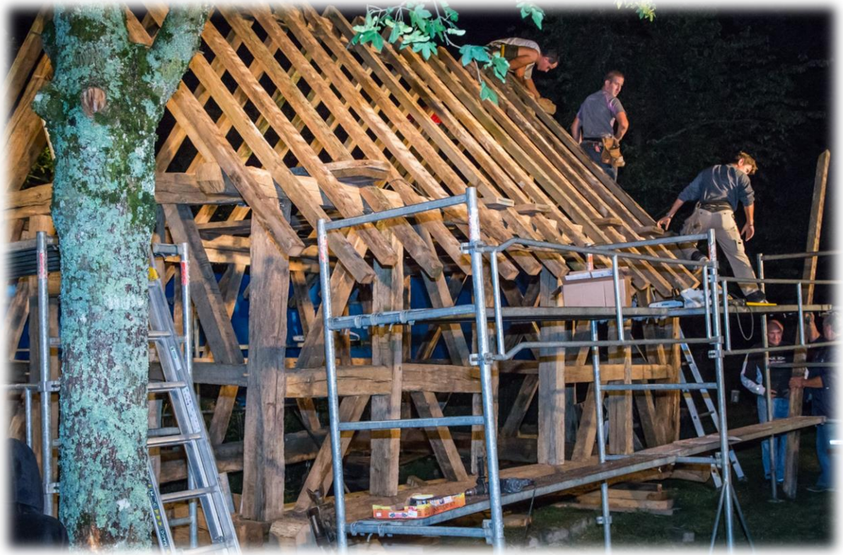
Figure 16 : Construction de la cabane de la Grange Rouge - K-bane de Bresse - Grange Rouge, juillet 2014
